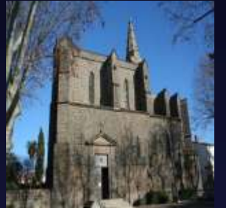
Vue d'ensemble côté Sud et portail principal
