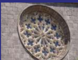
Rosace polylobée de 5 m de diamètre
