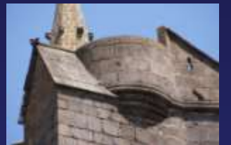
Une échauguette, avancée placée en surplomb à l'angle du mur permettant le guet
