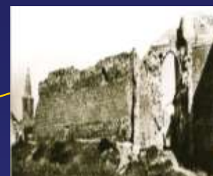
Porte de la mer Avant démolition Vestige du rempart qui ceinturait la ville. On a idée avec ce pan de mur du matériau utilisé et de son épaisseur.
